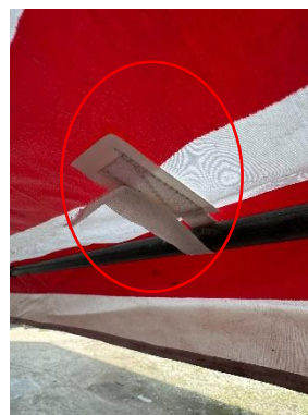
Dakzeil vast maken d.m.v. de velcro rond de ronde buizen
