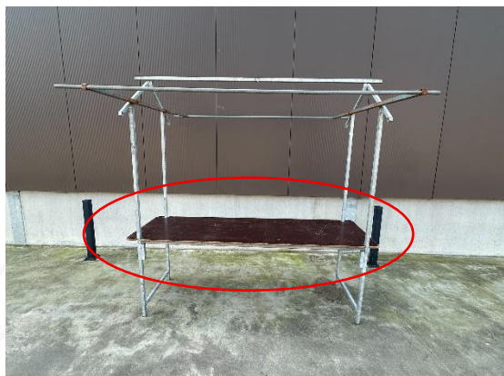
Houten plaat plaatsen
