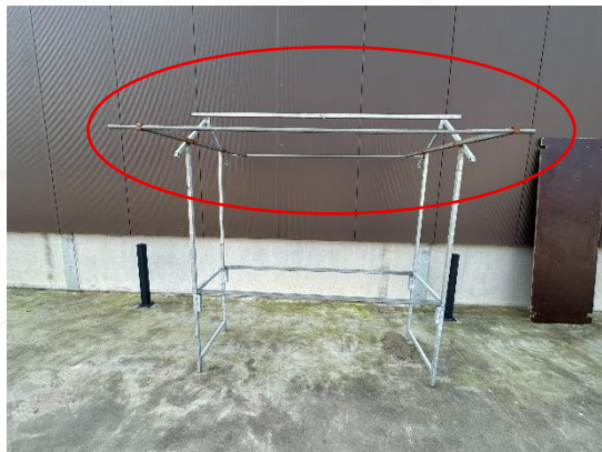
Top liggers + 2 ronde buizen plaatsen
