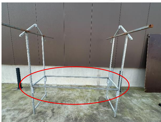
2 horizontale liggers plaatsen
